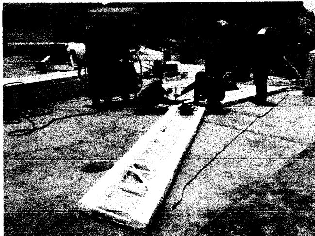
Vista de la habilitacion de las vigas principales T-1.
