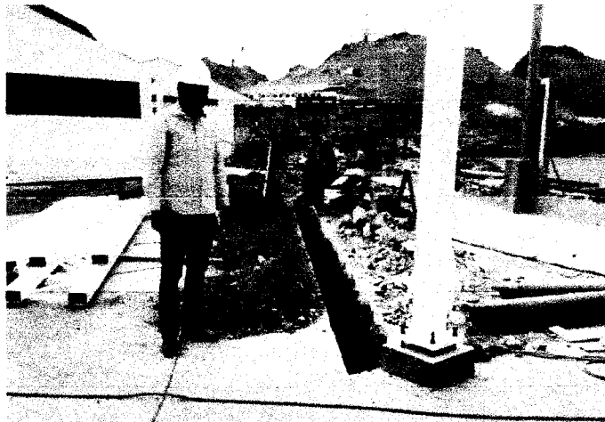
Vista de la verificación de los trabajos de excavación manual para zanja del alimentador eléctrico.
