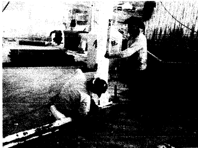
Vista de los trabajos de nivelacion de los parantes.
