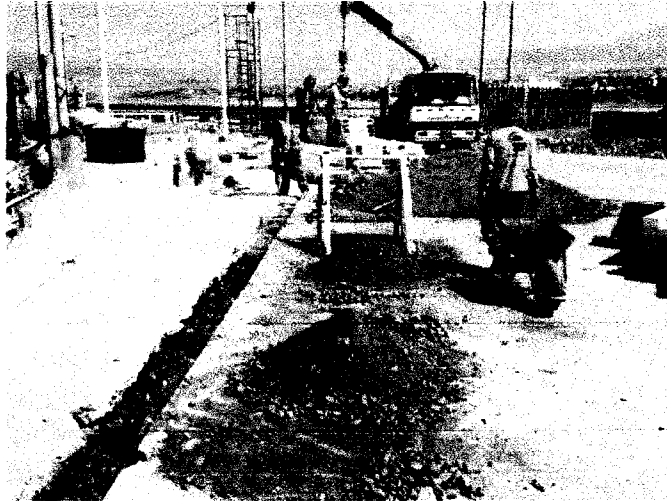
Vista de los trabajos de excavación manual para zanja del alimentador eléctrico.
