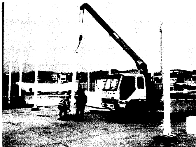
Vista de los trabajos de izaje y montaje de los parantes, zona 3.
