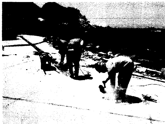
Vista de los trabajos de corte de losa de concreto para alimentador eléctrico.
